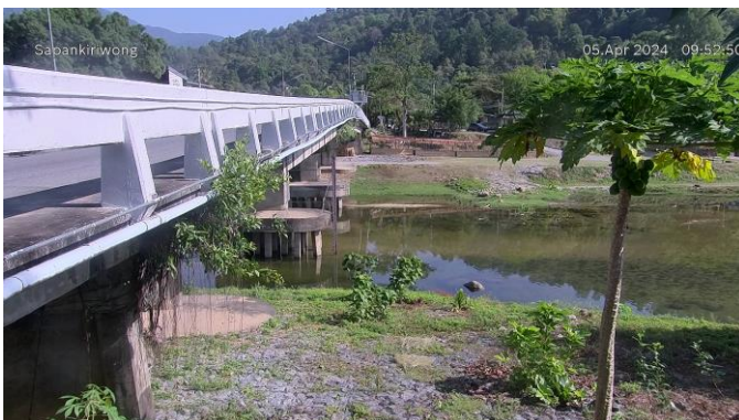
TC191913 : สะพานคีรีวง ต.กำโลน อ.ลานสกา จ.นครศรีธรรมราช
