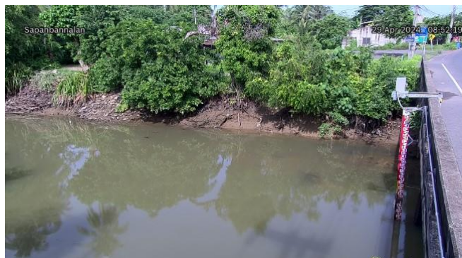
TC221203 : สะพานบ้านนาลาน ต.ควนซัน อ.เมืองสตูล จ.สตูล
