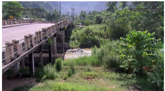
TC220510 : สะพานฝ่ายท่าสามัคคี ต.ถ้ำน้ำผุด อ.เมืองพังงา จ.พังงา
