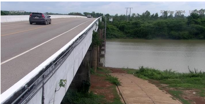
TC032705 : สะพาน นพ.4059 ต.ท่าบ่อสงคราม อ.ศรีสงคราม จ.นครพนม
