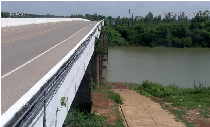
TC032705 : สะพาน นพ.4059 ต.ท่าบ่อสงคราม อ.ศรีสงคราม จ.นครพนม
