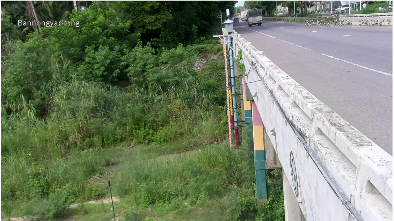
TC180701 : สะพานบ้านหนองหญ้าปล้อง ต.ชัยเกษม อ.บางสะพาน จ.ประจวบคีรีขันธ์
