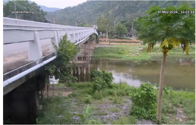
TC191913 : สะพานคีรีวง ต.กำโลน อ.ลานสกา จ.นครศรีธรรมราช
