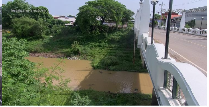
TC031703 : สะพานห้วยหลวงอนุสรณ์ ต.จุมพล อ.โพนพิสัย จ.หนองคาย
