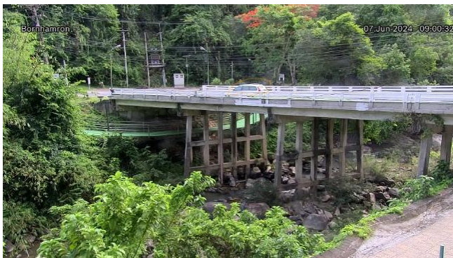
TC220303 : สะพานบ่อน้ำร้อน ต.บางรี อ.เมืองระนอง จ.ระนอง
