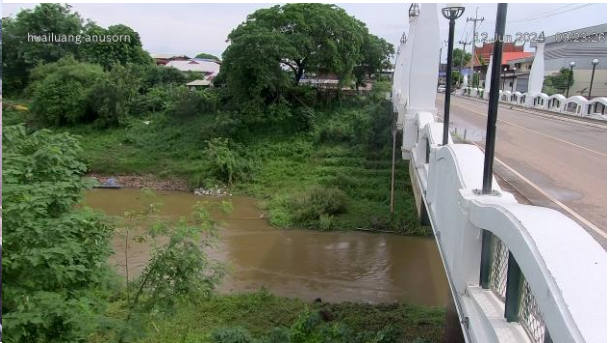
TC031703 : สะพานห้วยหลวงอนุสรณ์ ต.จุมพล อ.โพธิ์ชัย จ.หนองคาย
