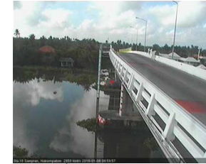
สะพานบุญรัตนประชาคุณวัฒน์ - อ.สามพราน จ.นครปฐม (ลุ่มน้ำท่าจีน)
