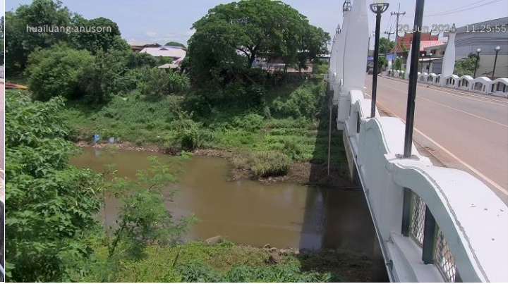
TC031703 : สะพานห้วยหลวงอนุสรณ์ ต.จุมพล อ.โพนพิสัย จ.หนองคาย
