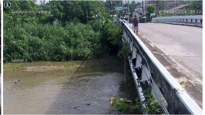
TC191001 : สะพานข้ามแม่น้ำตาปี ตลาดฉวาง
