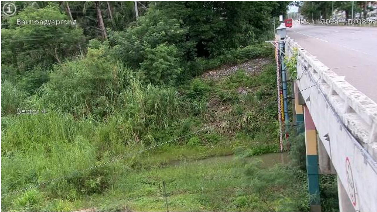
TC180701: สะพานบ้านหนองหญ้าปล้อง ต.ชัยเกษม อ.บางสะพาน จ.ประจวบคีรีขันธ์
