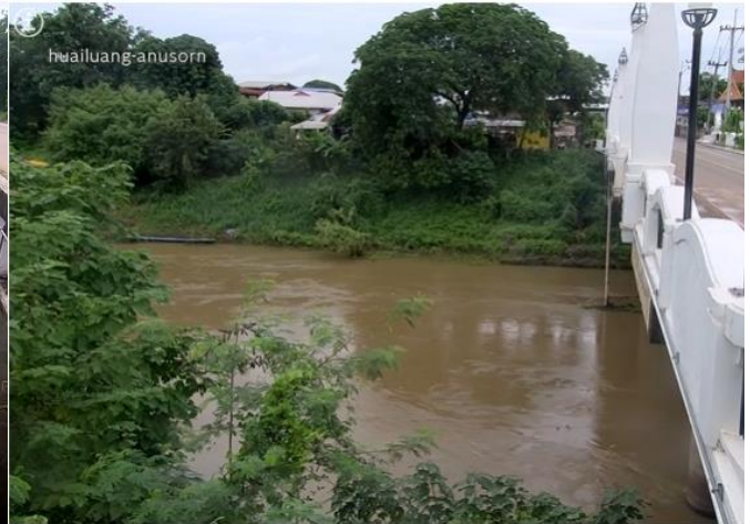
C031703 : สะพานห้วยหลวงอนุสรณ์ ต.จุมพล อ.โพนพิสัย จ.หนองคาย
