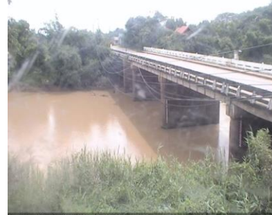
บ้านเหล่านกขุม - อ.เมือง จ.ขอนแก่น (ลุ่มน้ำชี)
