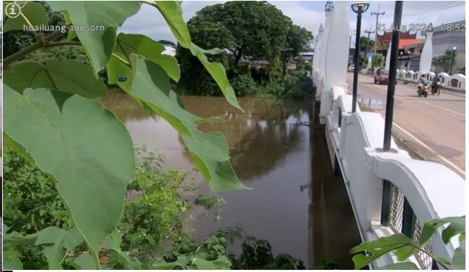
C031703 : สะพานห้วยหลวงอนุสรณ์ ต.จุมพล อ.โพนพิสัย จ.หนองคาย
