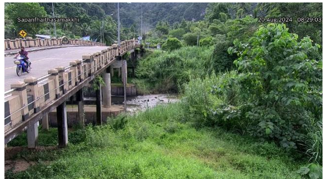
TC220510 : สะพานฝ่ายท่าสามัคคี ต.ถ้ำน้ำอ.เมืองพังงา จ.พังงา
