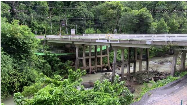
TC220303 : สะพานบ่อน้ำร้อน ต.บางรีน อ.เมืองระนอง จ.ระนอง
