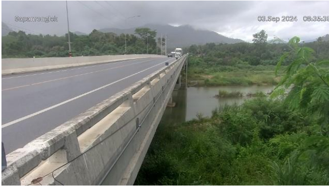
TC191802 : สะพานบ้านโรงเหล็ก ต.นบพิตำ อ.นบพิตำ จ.นครศรีธรรมราช
