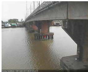
สภ.สุราษฎร์ธานี - อ.เมือง จ.สุราษฎร์ธานี (ลุ่มน้ำตาปี)
