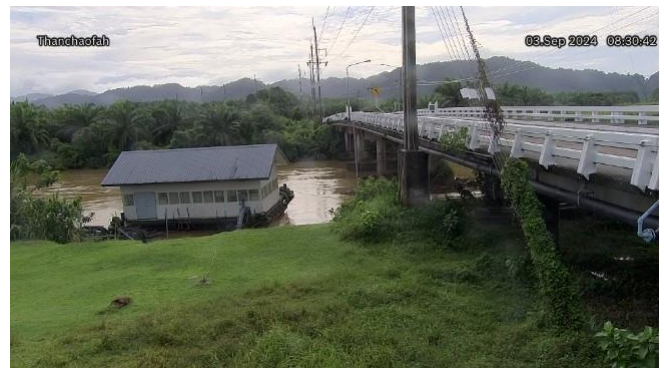
TC220402 : สะพานท่านเจ้าฟ้า ต.ตะกั่วป่า อ.ตะกั่วป่า จ.พังงา
