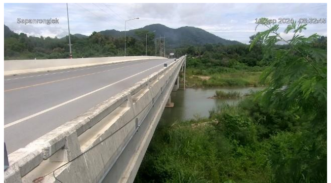
TC191802 : สะพานบ้านโรงเหล็ก ต.นบพิต อ.นบพิต จ.นครศรีธรรมราช
