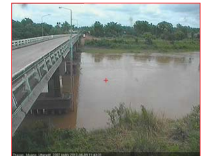
สถานีสะพานท่าเสา อ.เมือง จ.อุดรดิตถ์ (ลุ่มน้ำน่าน)
