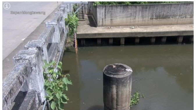
TC191912 : สะพานคลองท่าวัง เทศบาลนครนครศรีธรรมราช อ.เมือง จ.นครศรีธรรมราช
