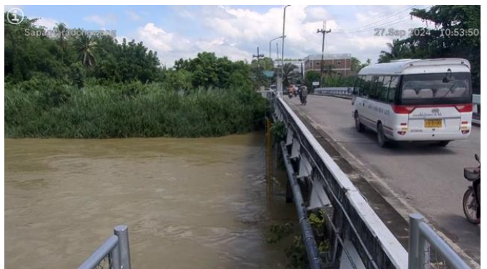
TC191001 : สะพานข้ามแม่น้ำตาปี ตลาดฉวาง ต.ฉวาง อ.ฉวาง จ.นครศรีธรรมราช
