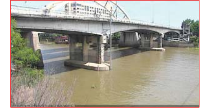
สถานีบ้านยางมนี่ ต.องครักษ์ อ.โพธิ์ทอง จ.อ่างทอง (ลุ่มน้ำเจ้าพระยา)
