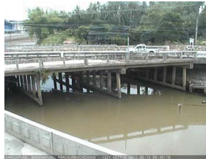
ร.ร.อนุบาลบางสะพาน - อ.บางสะพาน จ.ประจวบคีรีขันธ์ (คลองบางสะพาน/ชายฝั่งทะเลตะวันตก)
