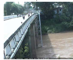
สะพานศรีสาขาลัย - อ.ศรีสาขาลัย จ.สุโขทัย (ลุ่มน้ำยม)
