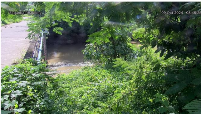
TC220512 : สะพานบ้านท่าคลอง ต.ทับปุด อ.เมืองกระบี่ จ.กระบี่
