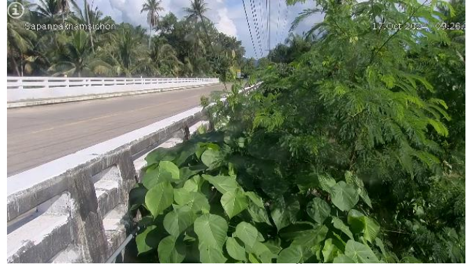
TC191705 : สะพานปากน้ำลิชล ต.ลิชล อ.ลิชล จ.นครศรีธรรมราช
