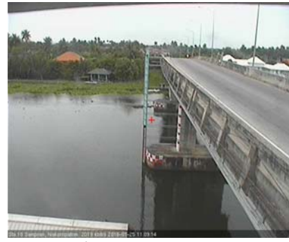
สะพานบุญรัตนประชนาวัดน์ - อ.สามพราน จ.นครปฐม (ลุ่มน้ำท่าจีน)
