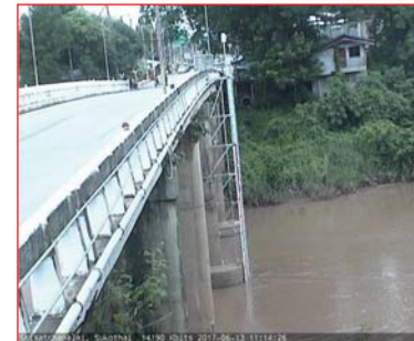
สถานีสะพานศรีรัตนาลัย อ.ศรีรัตนาลัย จ.สุโขทัย (ลุ่มน้ำยม)
