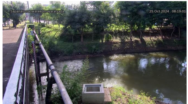
TC220904 : สะพานอนุสาวรีย์ พระยารัษฎานุประดิษฐ์มหิศรภักดี ต.ทับเที่ยง อ.เมืองตรัง จ.ตรัง
