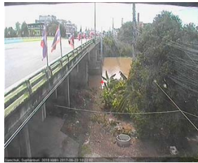
สะพานข้ามแม่น้ำท่าจีน ทางหลวง๓๓๖๕ อ.สามชุก จ.สุพรรณบุรี (ลุ่มน้ำท่าจีน)
