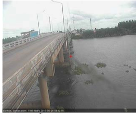
สะพานข้ามแม่น้ำท่าจีน 3 - อ.เมือง จ.สมุทรสาคร (ลุ่มน้ำท่าจีน)
