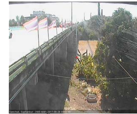
สะพานข้ามแม่น้ำท่าจีน ทางหลวง3365 อ.สามชุก จ.สุพรรณบุรี (ลุ่มน้ำท่าจีน)
