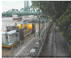
สะพานพุทธ - เขตธนบุรี จ.กรุงเทพฯ (ลุ่มน้ำเจ้าพระยา)
