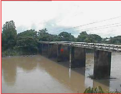
สถานีบ้านตลปักษ์น้ำ ต.ไชยบุรี อ.ท่าอุเทน จ.นครพนม (ลุ่มน้ำโขง)
