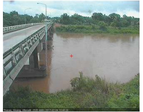
สะพานท่าเสา - อ.เมือง จ.อุตรดิตถ์ (ลุ่มน้ำน่าน)
