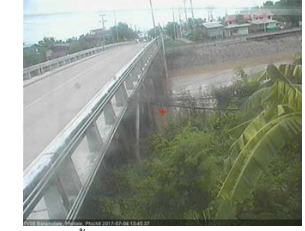
สะพานบ้านโพทะเล - อ.โพทะเล จ.พิจิตร (ลุ่มน้ำยม)
