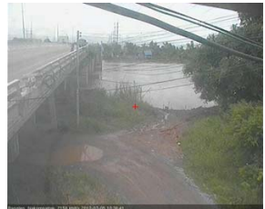
สะพานข้ามแม่น้ำท่าจีน ทางหลวง346 อ.บางเลน จ.นครปฐม (ลุ่มน้ำท่าจีน)
