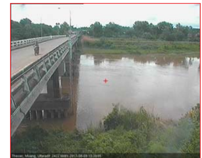
สถานีสะพานท่าเสา อ.เมือง จ.อุดรดิตต์ (ลุ่มน้ำน่าน)
