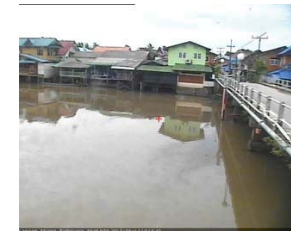
สถานีลำปำ - อ.เมือง จ.พัทลุง (ลุ่มน้ำทะเลสาบสงขลา)
