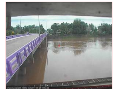
สถานีสะพานเฉลิมพระเกียรติ 48 พระยา อ.เมือง จ.พิจิตร (ลุ่มน้ำน่าน)
