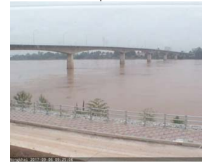
สนง.ส่วนอุทกหนองคาย - อ.เมือง จ.หนองคาย (ลุ่มน้ำโขง)
