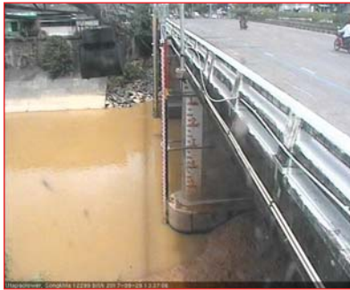
สถานีคลองคูตะภาคอนล่าง - ต.หาดใหญ่ อ.หาดใหญ่ จ.สงขลา (ลุ่มน้ำทะเลสาบสงขลา)
