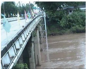
สะพานศรีษะขาลัย - อ.ศรีษะขาลัย จ.สุโขทัย (ลุ่มน้ำยม)
