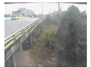
สะพานข้ามแม่น้ำท่าจีน ทางหลวง3365 อ.สามชุก จ.สุพรรณบุรี (คู่น้ำท่าจีน)
