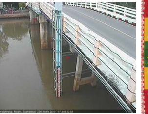
สะพานวัดพระรูป อ.เมือง จ.สุพรรณบุรี (คู่น้ำท่าจีน)
