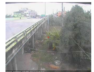
สะพานข้ามแม่น้ำท่าจีน ทางหลวง 3365 อ.สามชุก จ.สุพรรณบุรี (คู่น้ำท่าจีน)
