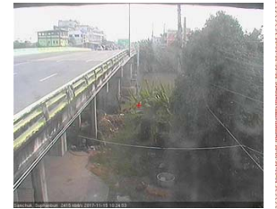
สะพานข้ามแม่น้ำท่าจีน ทางหลวง3365 อ.สามชุก จ.สุพรรณบุรี (ลุ่มน้ำท่าจีน)
