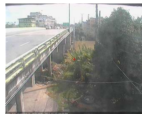
สะพานข้ามแม่น้ำท่าจีน ทางหลวง3365 อ.สามพราน จ.สุพรรณบุรี (ลุ่มน้ำท่าจีน)
