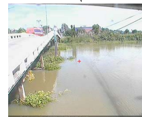
สะพานสามง่าม-ท่าโสมสอ อ.หันคา จ.ชัยนาท (ลุ่มน้ำท่าจีน)
