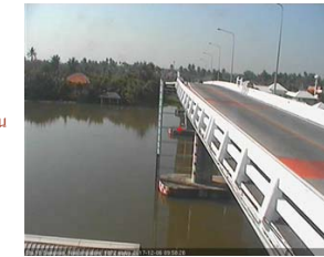
สะพานบุญรัตนประชาคุณัดน์ - อ.สามพราน จ.นครปฐม (ลุ่มน้ำท่าจีน)
