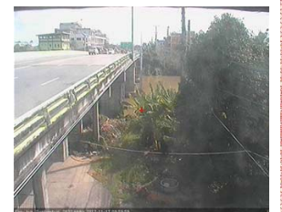
สะพานข้ามแม่น้ำท่าจีน ทางหลวง3365 อ.สามพราน จ.สุพรรณบุรี (คู่น้ำท่าจีน)
