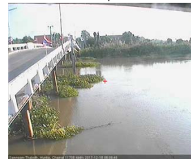
สะพานสามงาม-ท่าโบสถ์ อ.หันคา จ.ชัยนาท (คู่น้ำท่าจีน)
